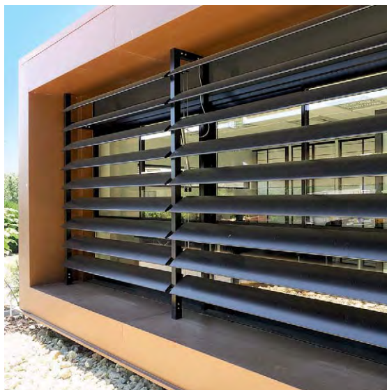
Architectes : J-P. Dhalluin et P. Peny - Photographe : Patrick Loubet
